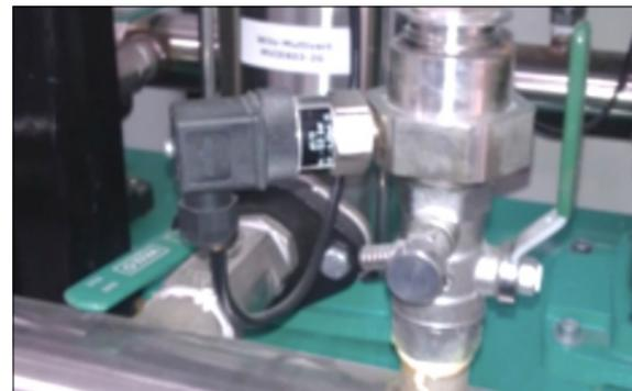
检测管内液体压力
